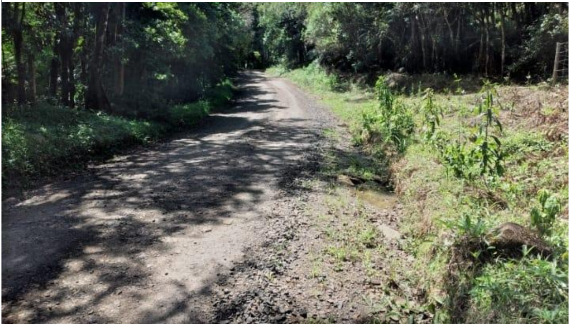
Figura 14 - Terraplenagem em estrada e produção agrícola – (Ponto 2)
