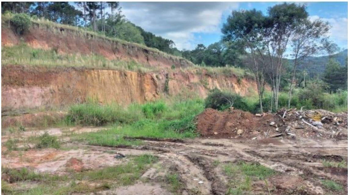
Figura 25 - Taludes de corte para retirada de material e acúmulo de entulho – (Ponto 7)
