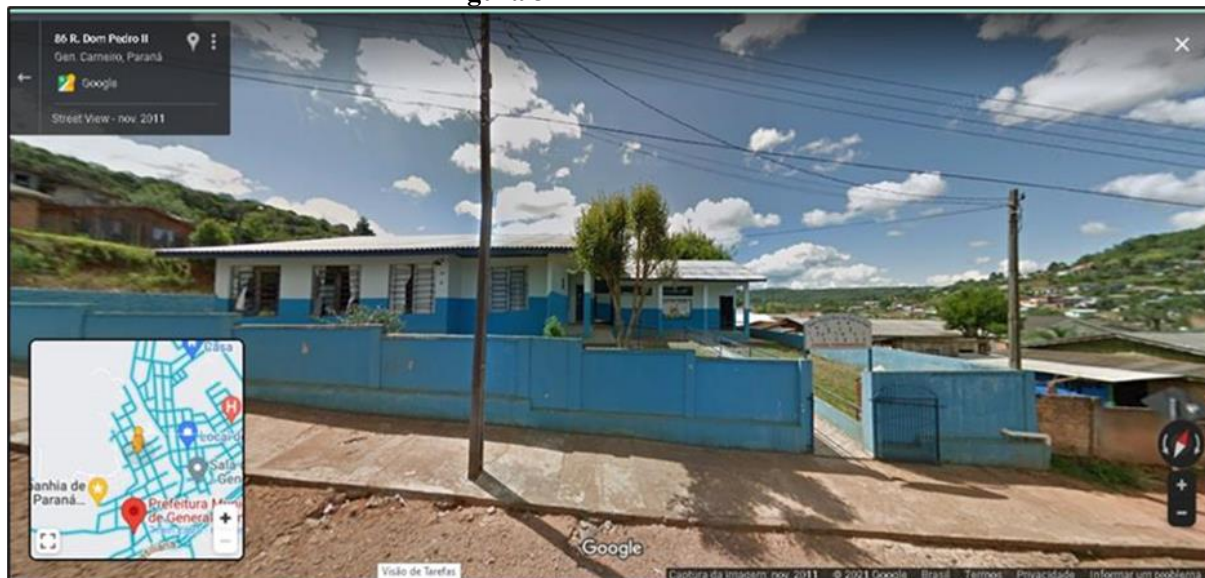
Figura 3 - Fachada da escola
