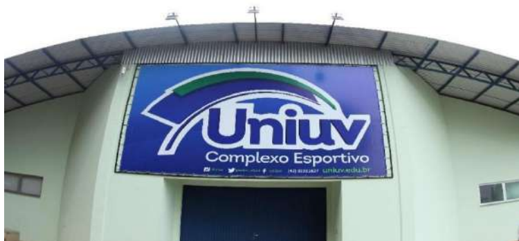
Figura 9 – Fachada do Complexo Esportivo
